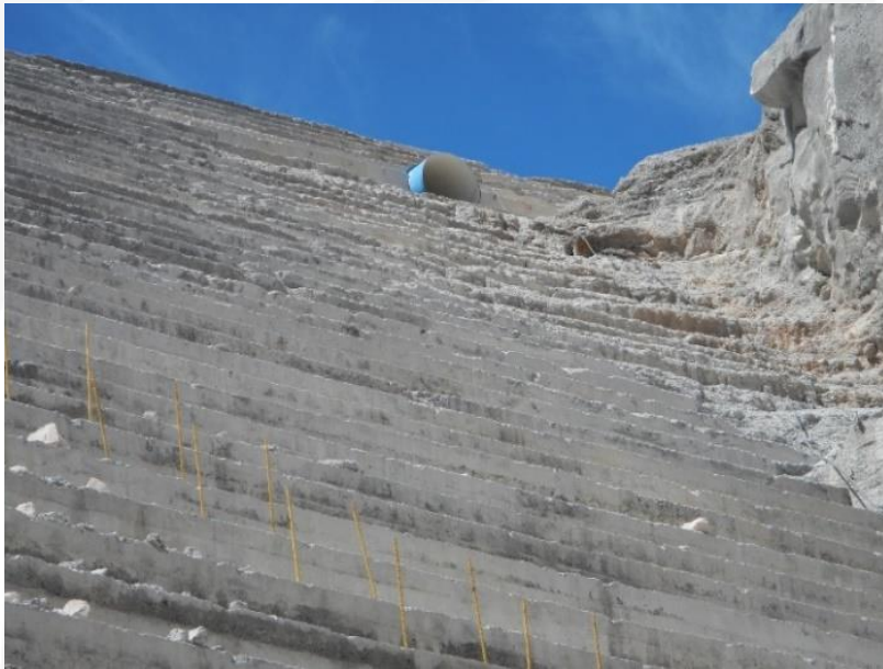
Foto 3. Vista de tubería de descarga en el talud de aguas abajo
