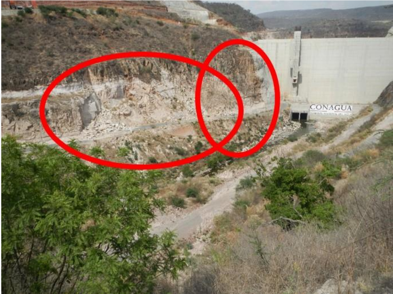
Foto 11. Deslizamientos M Izquierda aguas arriba desvío y talud inestable
