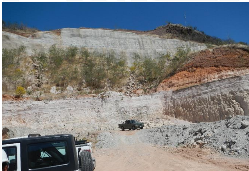
Foto 4. Cortes y excavación del empotramiento de los módulos de margen izquierda
