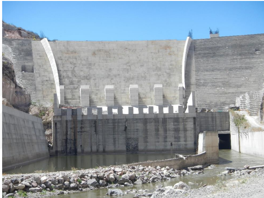
Foto 9. Vista desde aguas abajo, pileta de aquietamiento y vertedero
