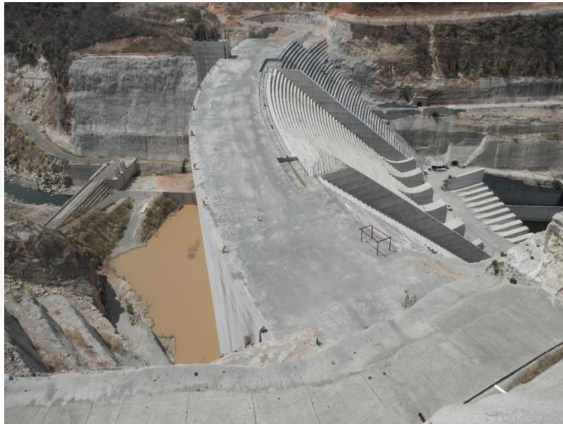
Foto 6. Vista superior desde margen derecha – Presa y Vertedero
