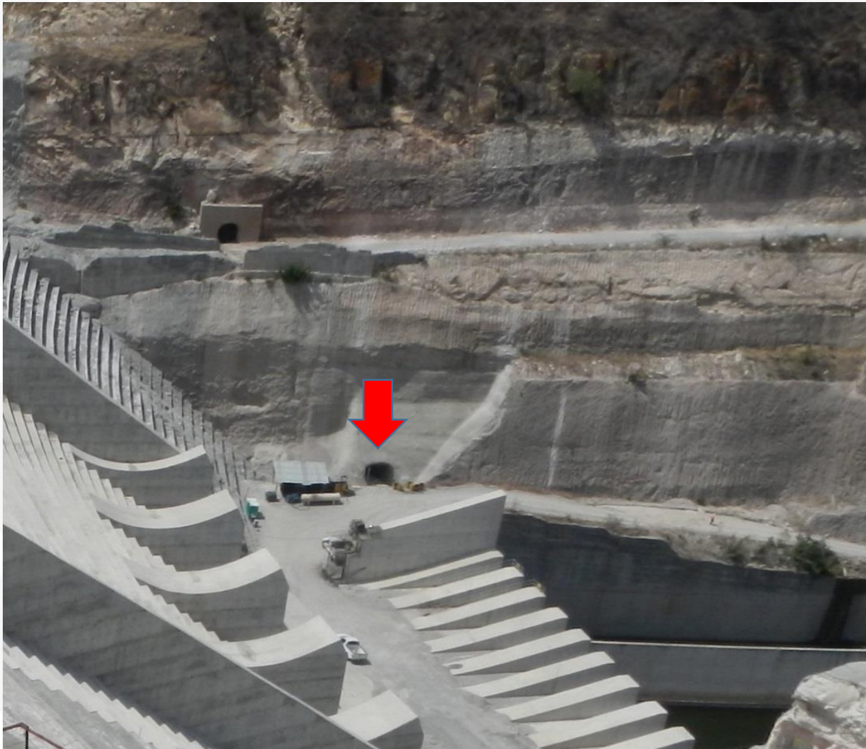
Foto 16. Galerías de acceso margen izquierda
