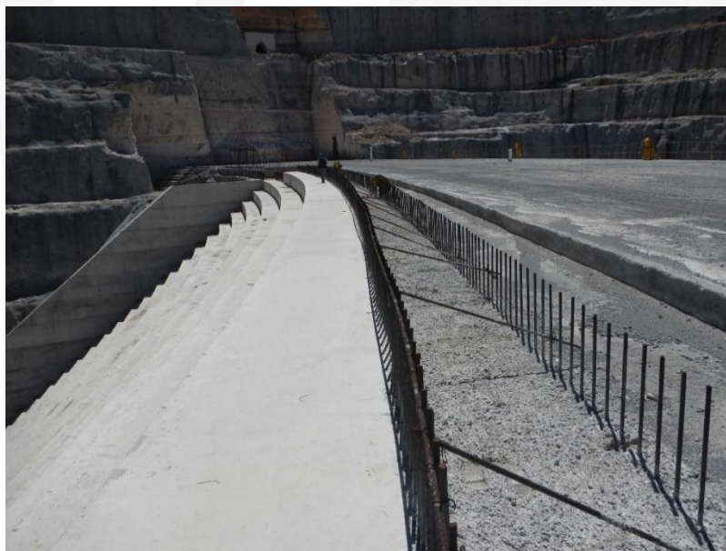
Foto 7. Presa a cota 1,629.70 y vertedero escalonado
