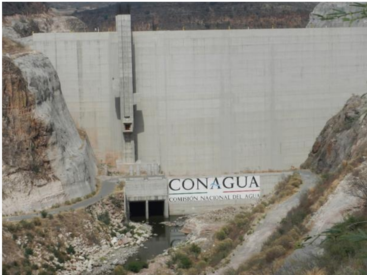
Foto 12. Toma N°1, ataguía y embocadura de conductos de desvío
